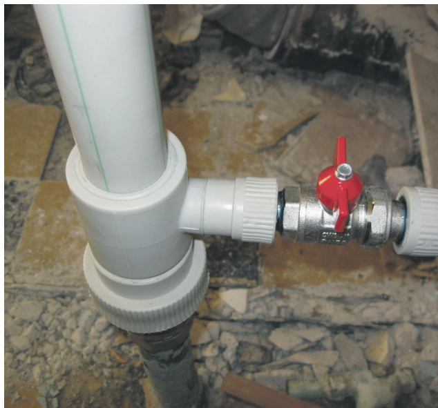
▲ Замена специалистами старых труб на новые
